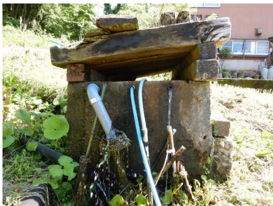
図 4.4.2 トンネルの水
